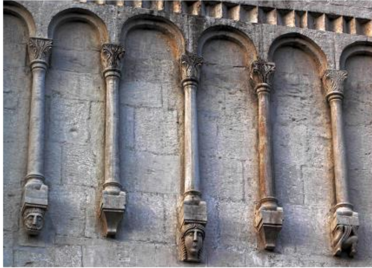
Аркатурно-колончатый пояс на фасаде
