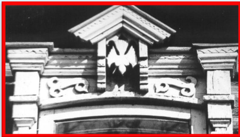
Оконный наличник по ул. Суворова, 82
