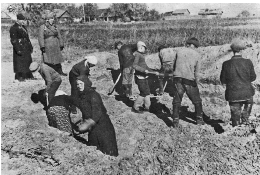
Возведение земляных укреплений на правом берегу р. Суры. С. Пыркино. Ноябрь 1941 г.
